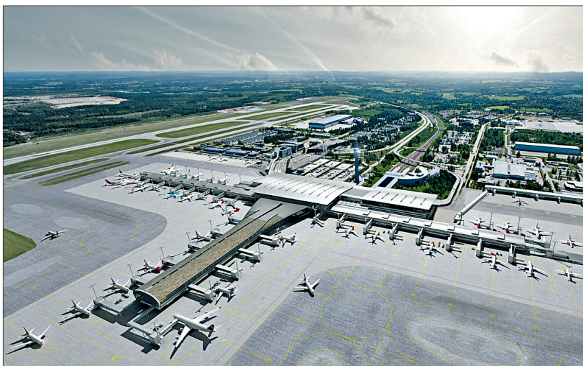
Aus der Vogelperspektive ist die Röhrenform der neuen, mit schwedischen Eichenholz-Lamellen bekleideten Landungsbrücke Pier Nord gut zu erkennen. Sie schließt direkt an den Terminal 1 an. Foto: Oslo Lufthavn AS
