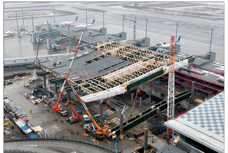
Der gesamte Bauprozess erfolgte bei laufendem Flugbetrieb und steigendem Fluggastaufkommen ohne große Verzögerungen. Foto: Oslo Lufthavn AS
