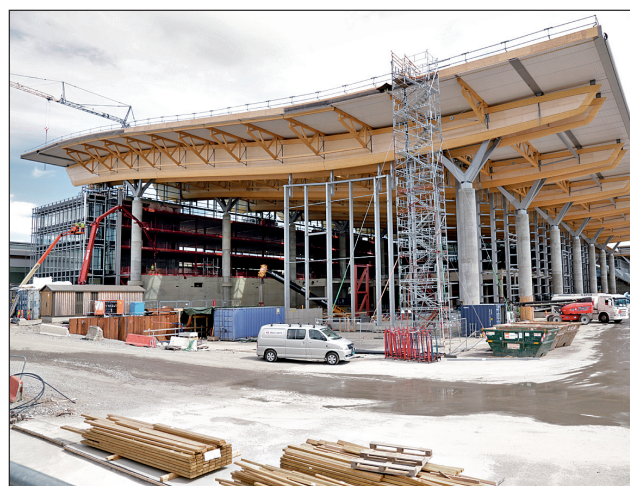
Die 90 m überspannenden BSH-Dachbinder der Passagier-Abfertigungshalle Sentralbygning Vest werden von Betonstützen getragen. Foto: Derix/Poppensieker & Derix
