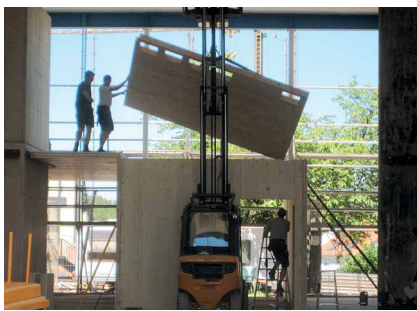
Abb. 11: Einheben der BSP-Elemente
