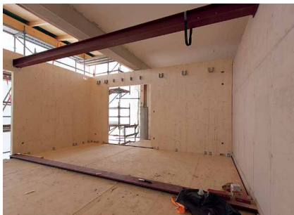
Abb. 13: Montage der vorgefertigten Wand- und Bodenelemente
