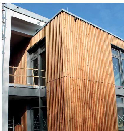
Abb. 26: Außenfassade aus Douglasienholz
